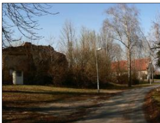
obr.č. 89 Úsek na p.č. 676/1 určený k vyčištění K1.
